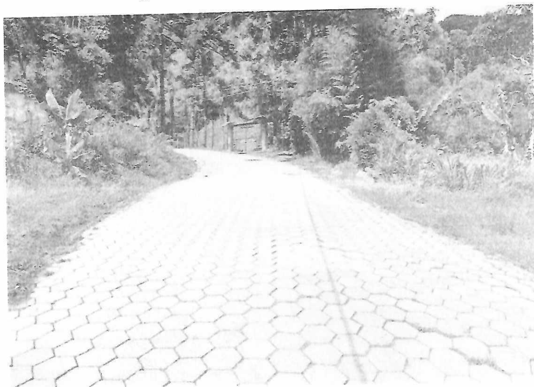
Imagem 13 – Vista da Estrada no sentido de Marmelópolis
