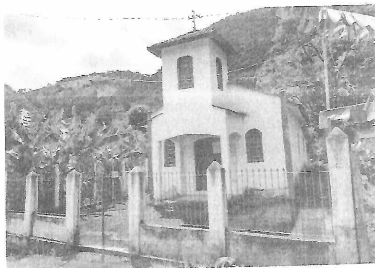
Imagem 11 – Vista da Capela que fica em frente a Escola
